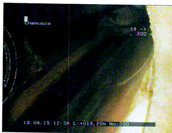
fotografia: 7b, Video nº: 01, 00:12:34 19,2m, Fim da inspeção
