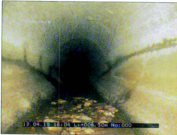
fotografia: 8a, Vídeo nº: 01 0m, Início da inspeção
