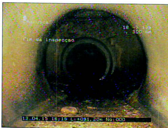
fotografia: 9a, Vídeo nº: 01, 00:09:52 31,2m, Fim da inspeção
