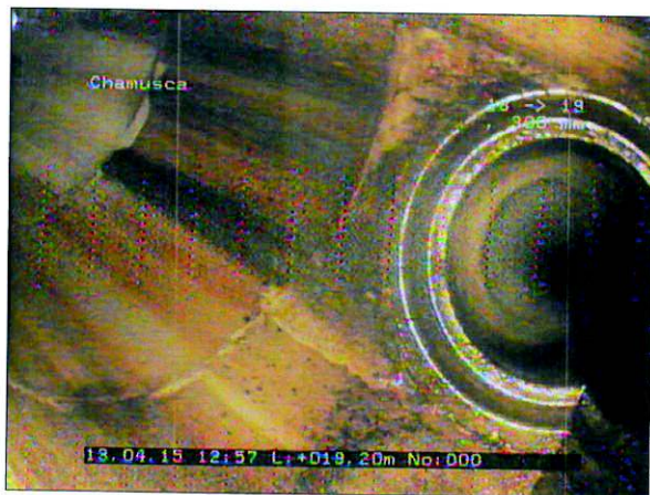
fotografia: 7a, Video nº: 01, 00:12:34 19,2m, Fim da inspeção
