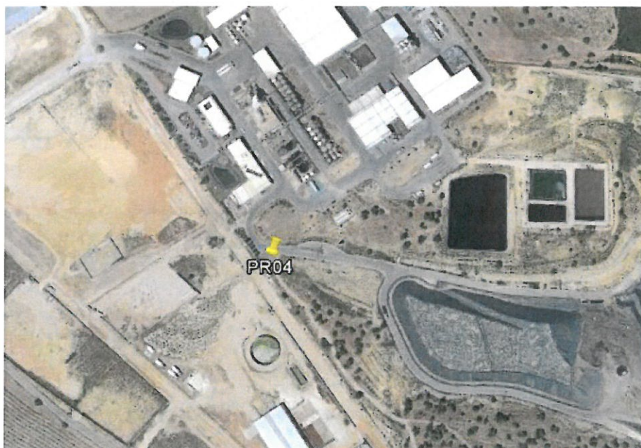
Figura 5 - Localização do ponto de monitorização PR04
