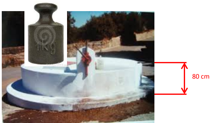
Figura 22 – Poço com cobertura e resguardo eficaz
