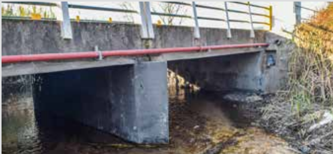
Requalificação da Ponte da Vala da Ribeira de Ulme
