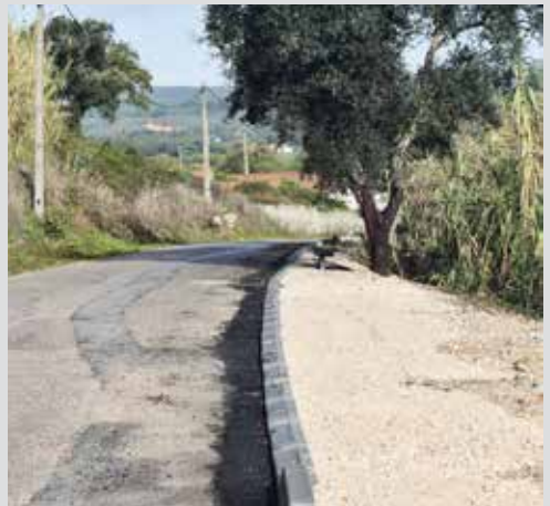
Reparação da Rua Cova Funda
