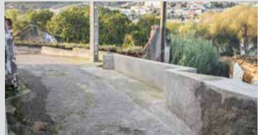
Muro de Suporte | Rua da Sociedade
