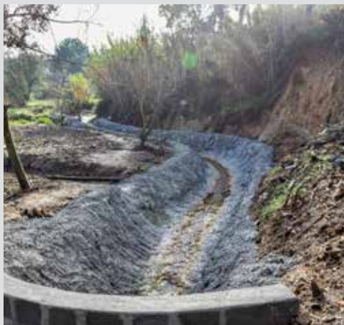
Reabilitação da Vala de Estrema - Fase II
