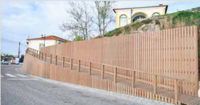
Rampa e Muro | Centro BTT
