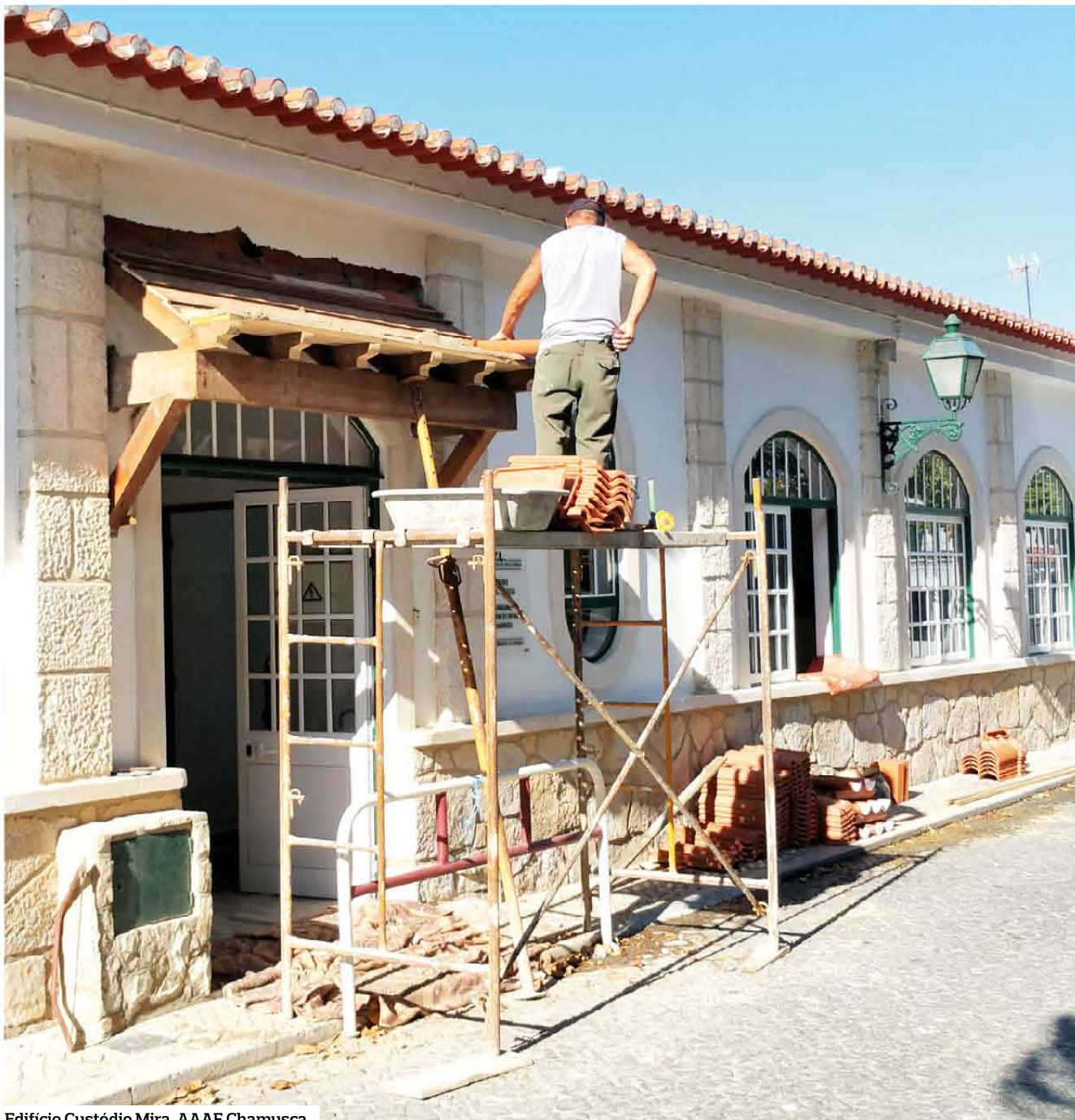
Edifício Custódio Mira, AAAF Chamusca
