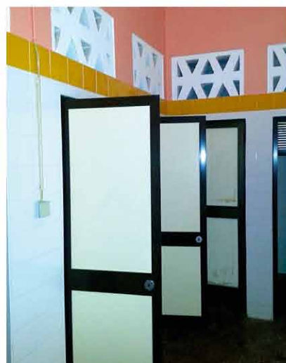
EB1 Chamusca: obras de melhoramento nos WC's
