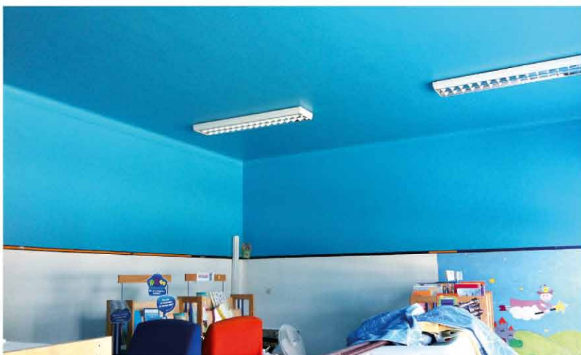
EB1 Chamusca: obras de melhoramento
