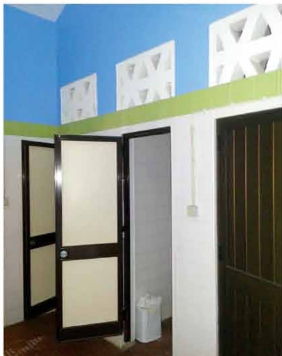
EB1 Chamusca: obras de melhoramento nos WC's
