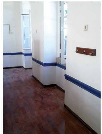
EB1 Ulme: aplicação do lambrim de azulejo e pinturas
